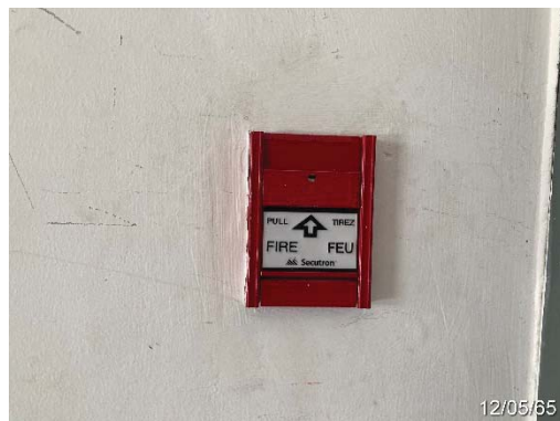
อุปกรณ์ส่งสัญญาณแจ้งเหตุเพลิงไหม้
