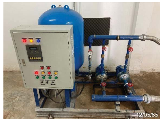
ถังเก็บน้ำบนดาดฟ้าและปั้มอาคาร B
